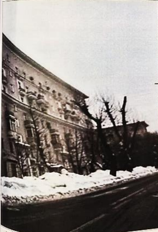
Фото 13 Общий вид корпуса №1 с улицы
