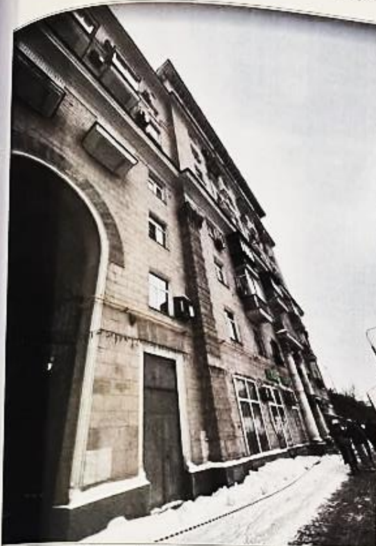
Фото 3 Общий вид корпуса №2 дом с улицы
