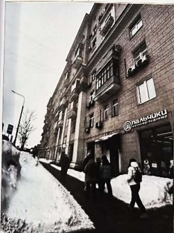
Фото 5 Общий вид корпуса №2 с улицы
