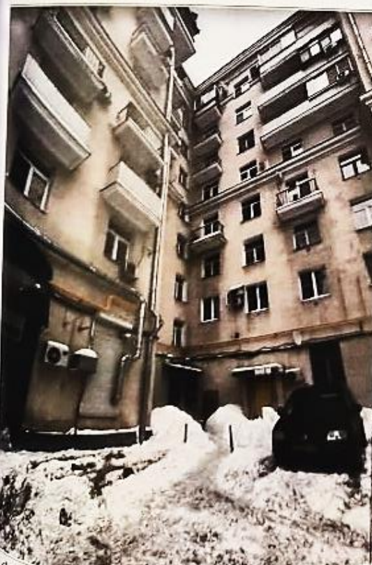
Фото 17 Общий вид корпуса №3 со двора
