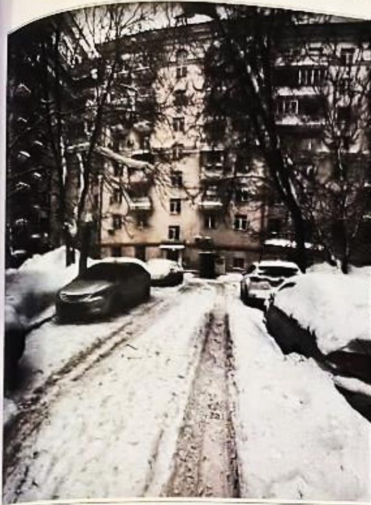
Фото 11 Общий вид корпуса №1 со двора
