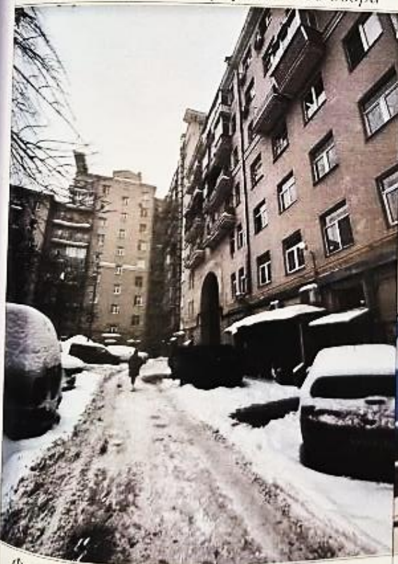
Фото 9 Общий вид корпуса №2 со двора
