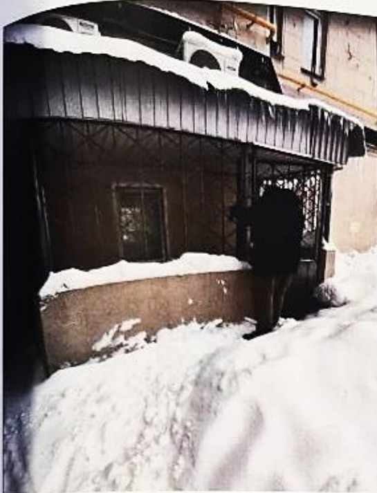
Фото 23 Вход в подвальные помещения
