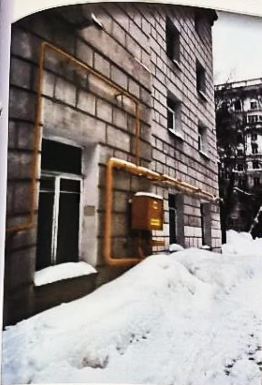
Фото 15 Общий вид корпуса №1 с улицы
