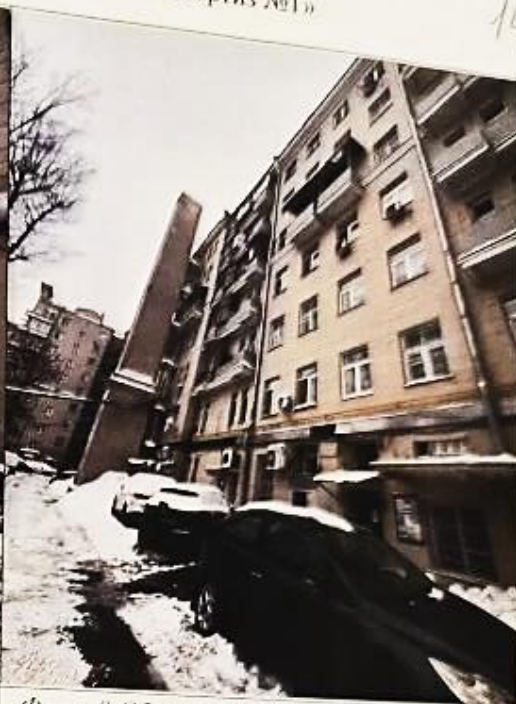
Фото 8 Общий вид корпуса №2 со двора
