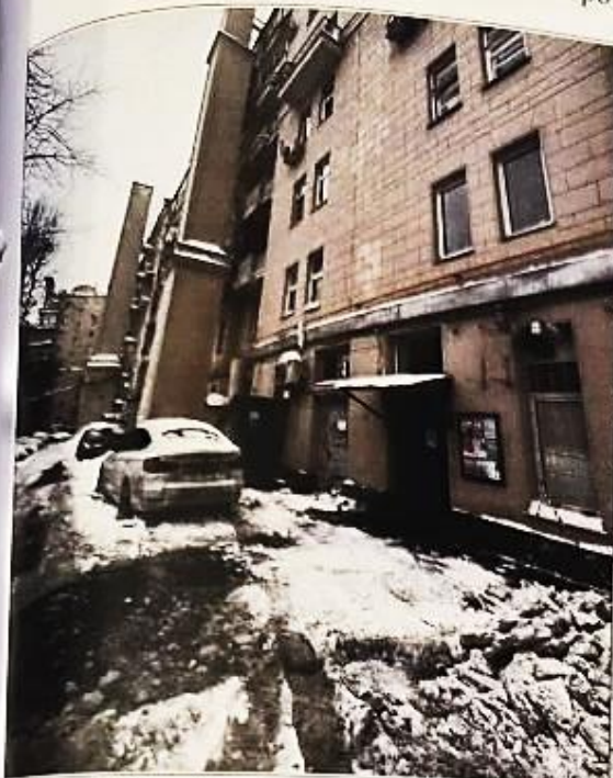
Фото 7 Общий вид корпуса №2 со двора
