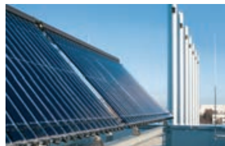
Солнечные коллекторы для отопления и охлаждения
