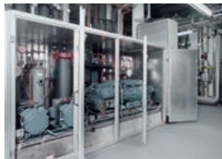
Индивидуальная концепция теплоснабжения тепловыми насосами для больших объектов
