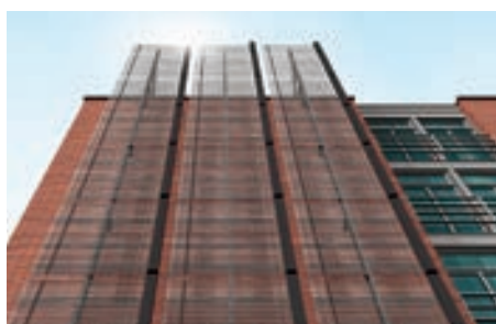
Город будущего, Malmö, Швеция, этот жилой дом получает необходимую тепловую энергию с помощью трубчатых солнечных коллекторов.
