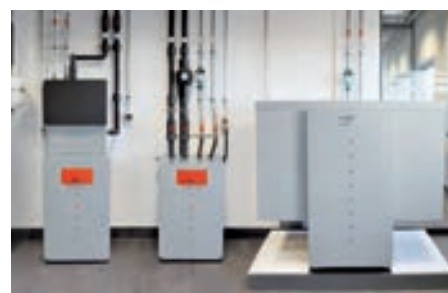
Тепловые насосы установленные в Академии Viessmann в рамках проекта „Effizienz Plus“.
