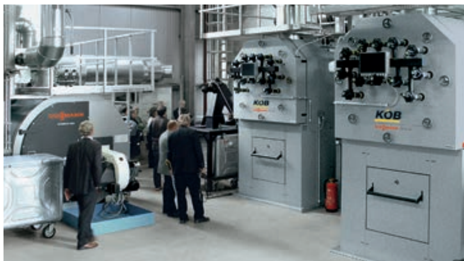
Твердотопливные древесные котлы и жидкотопливный водогрейный котел в составе энергоцентрали обеспечивают теплом 60 квартир муниципального округа.
