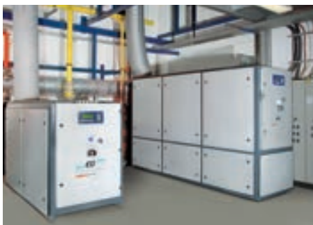
Когенерационные установки для производства тепловой и электрической энергии в диапазоне от 36 до 549 кВт эл.
