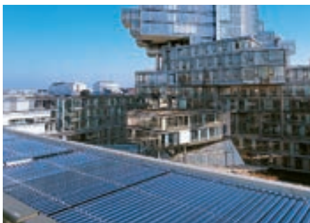
Солнечные коллекторы – идеальное решение для теплоснабжения
