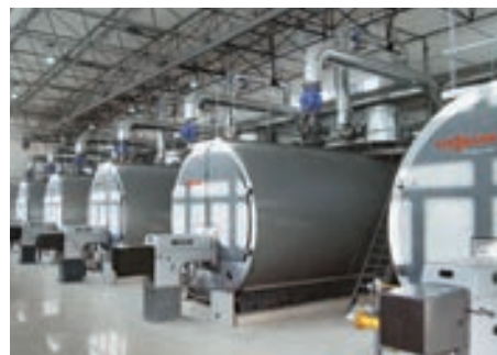
Котлы большой мощности до 20 МВт.
