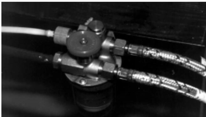
При переводе на однолинейную систему рекомендуется установка жидкотопливного фильтра с подводом обратной линии. При этом насос продолжает функционировать в двухлинейной системе. Присоединить входной и обратный шланги горелки к фильтру. Открыть топливный кран на фильтре. Произвести пуск установки.
