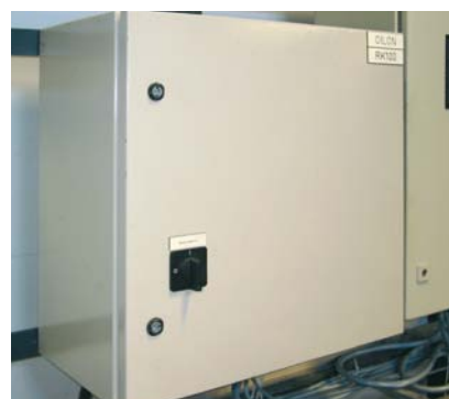
Силовой шкаф RK100
