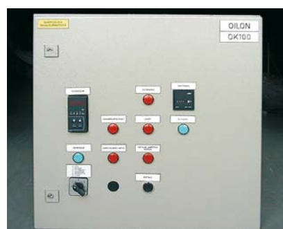
Шкаф управления ОК100
