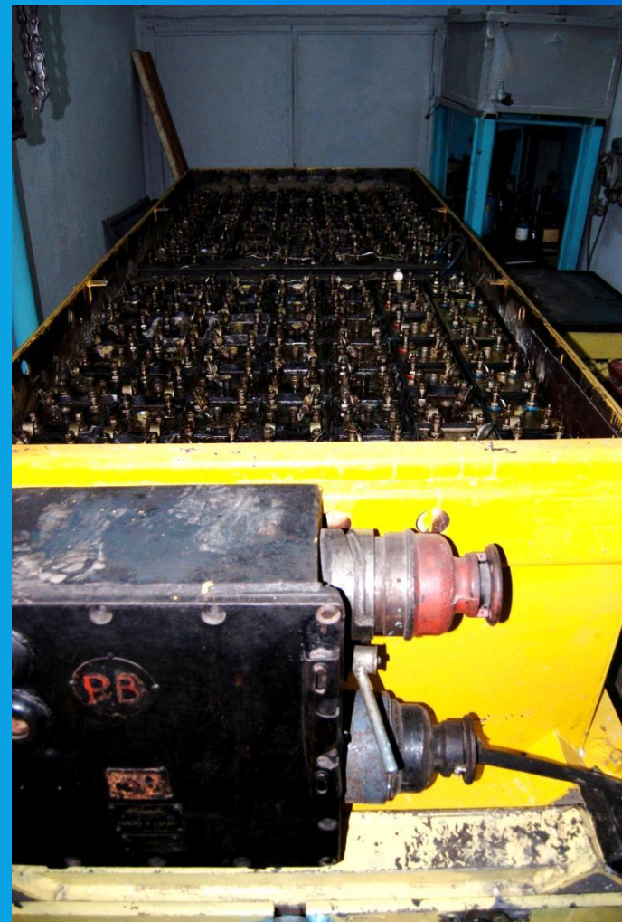
Батарея электровоза АМ-8Д
