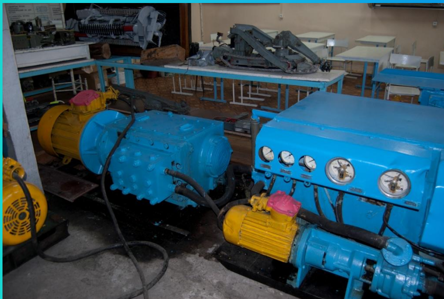
Насосная станция СНТ 32
