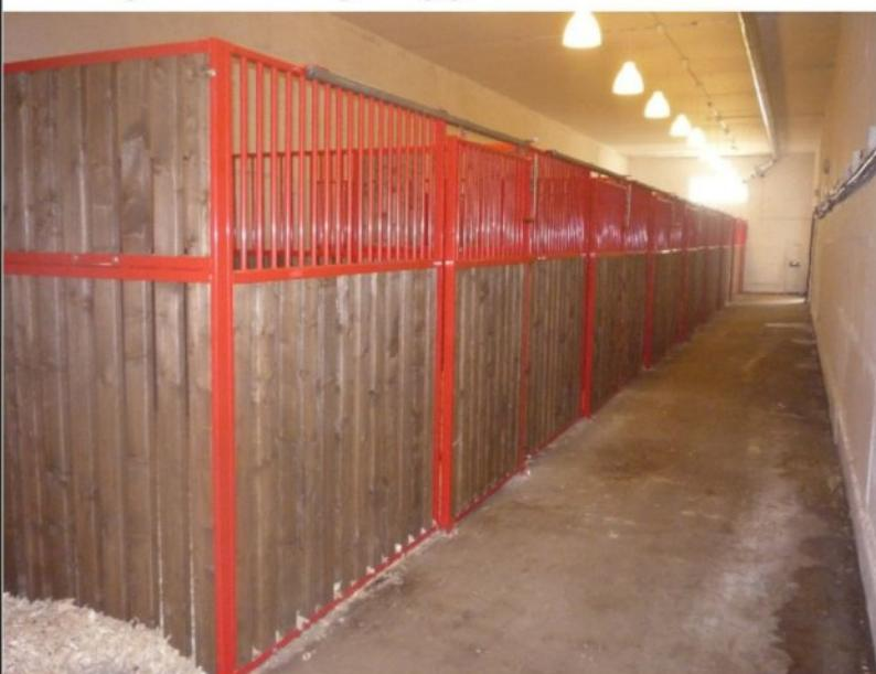
Размеры: фасад 3 м, боковая перегородка 3 м.
