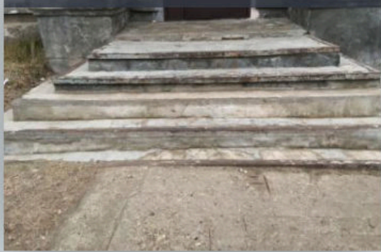
Фото лестницы на входе:
