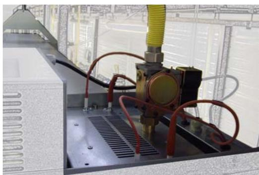
Соединение осуществляется на блоке горелки у входа газового блока (электрокалпана).
