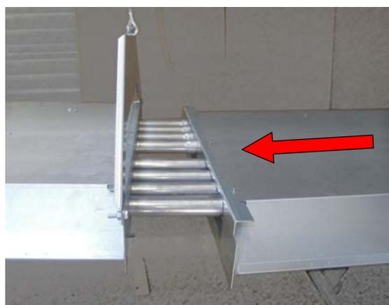
8- Вставить гайки в монтажные отверстия и закрепить. Начав с внутренних труб, потянуть излучающие трубы 2-го рефлектора, надев их на трубы 1-го рефлектора.
