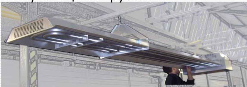
4) Подсоединить рефлектор с излучающими трубами к блоку горелки
