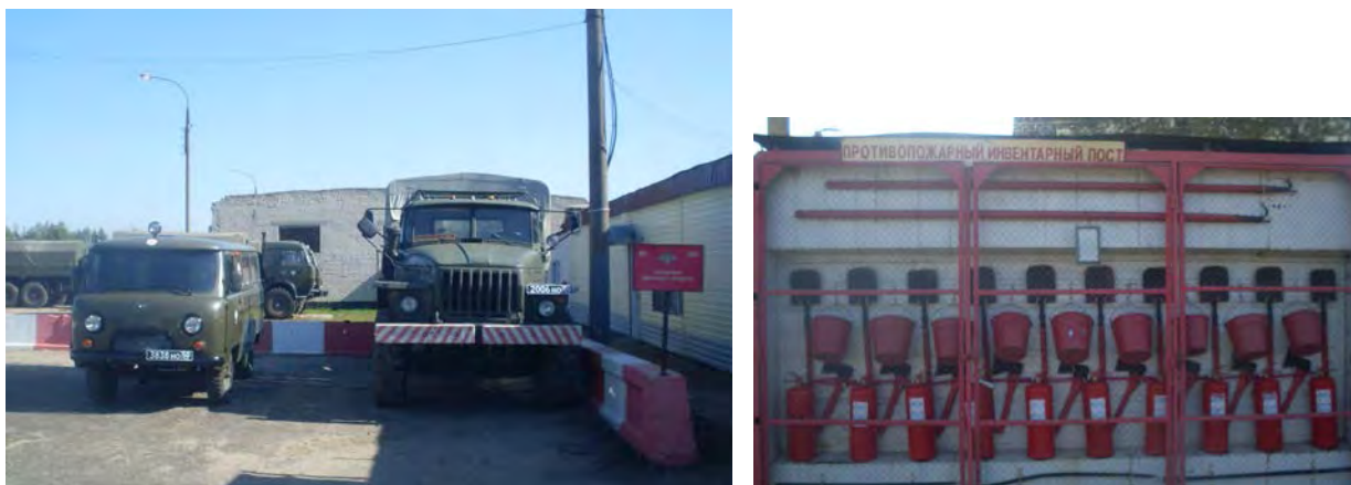
а а – общий вид площадки; б – пожарно-инвентарный пост
