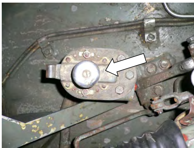
Рисунок 4.12 – Выключатель аккумуляторной батареи
