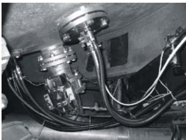
Пример применения разделителей S – TK wash в комплекте с преобразователем разности давлений типа APR – 2200.
